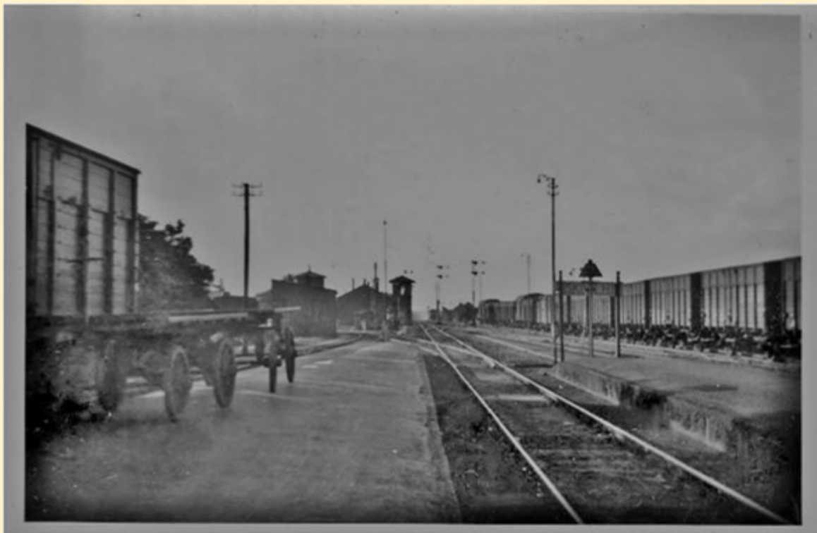
... og Skive Hovedbanegård Signal Blokpost Vest i virkeligheden. Billedet er fra Hovedbanegård med retning mod Viborg. Signal blokposten rejser sig i midten af billedet.
